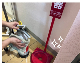
消火器のほこり・汚れ除去の様子
